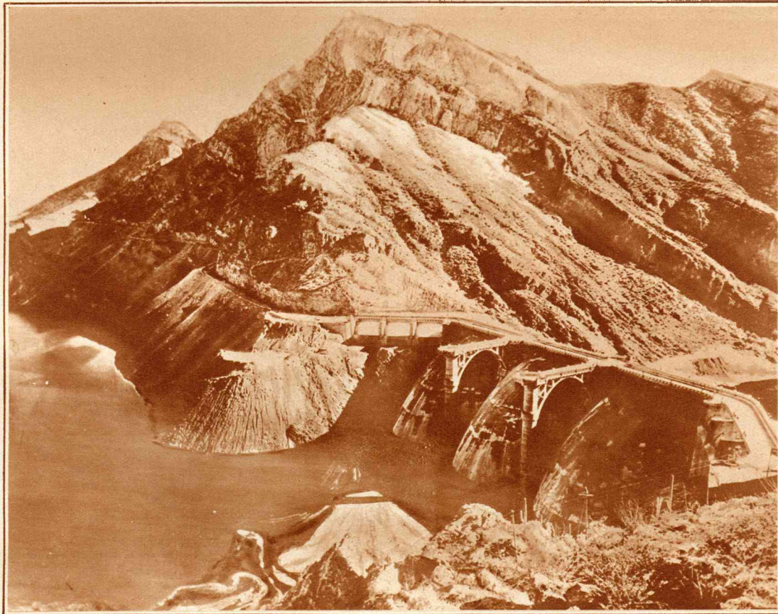
Niet alleen in de Maas kan men groote waterbouwkundige werken bewonderen, getuige deze foto van een geweldig stuwdam in het bergland van Arizona (Ver. Staten).
