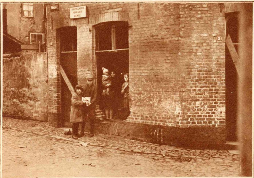
De jeugd heeft reeds een aanvang gemaakt met sloopen.
