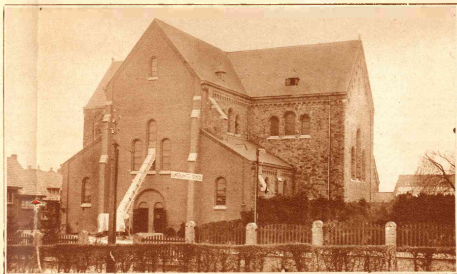
De R.K. Kerk te Chèremont (L.), welke reeds dertig jaar zonder toren is, begint door de mijnverzakkingen geweldige scheuren te krijgen, waardoor een groote restauratie noodig is.
