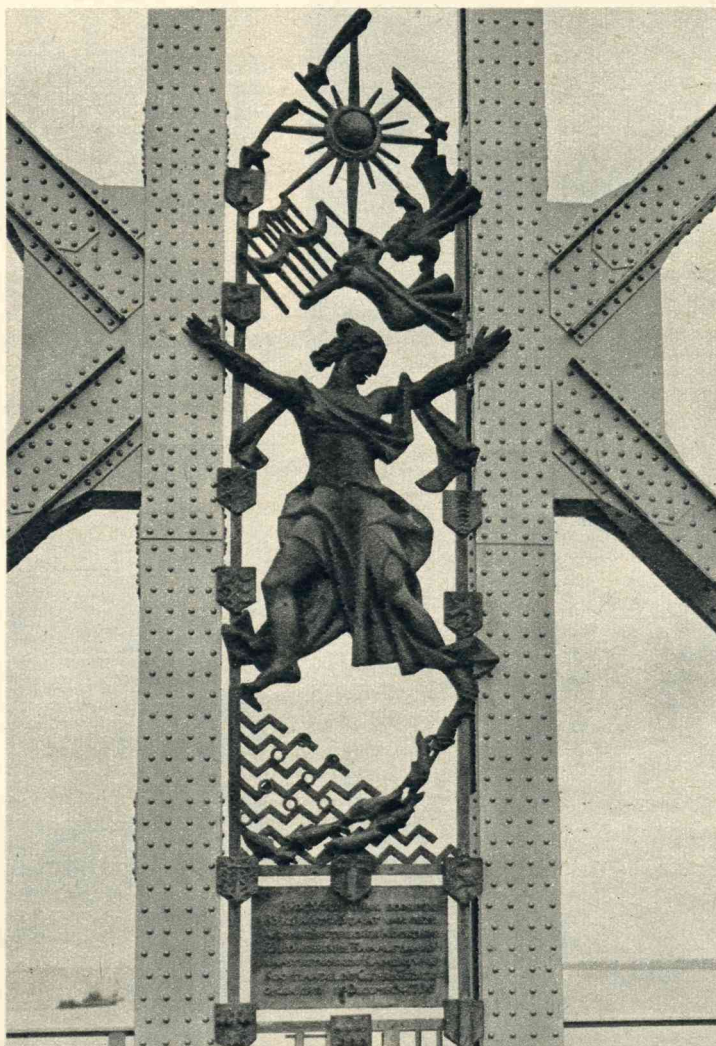
Het gedenkteeken op de nieuwe Moerdijkbrug, voorstellende de verbinding van Noord en Zuid. Boven: de elementen van sterren, zon en wind, onder: water en visschen.
