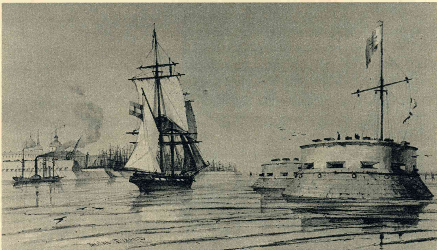
De reede van Kronstadt — met den bouw van het fort op den voorgrond werd de grondsteen van de nieuwe Russische hoofdstad gelegd.
