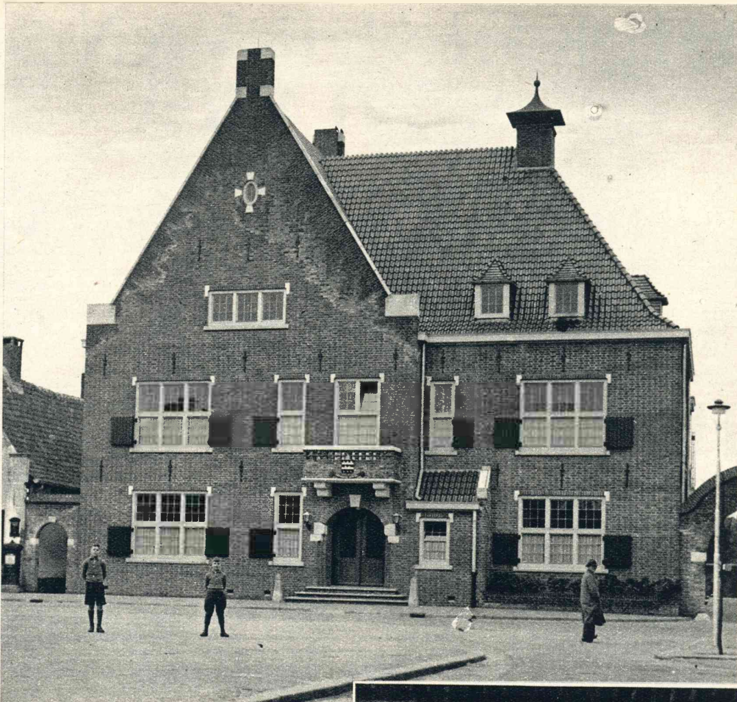
Vooraanzicht van het fraaie gebouw.
