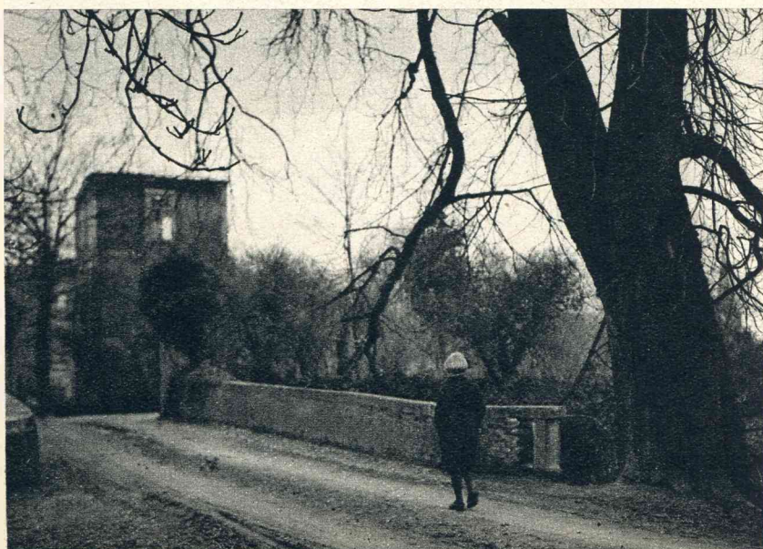
De steenen brug naar het kasteel.
