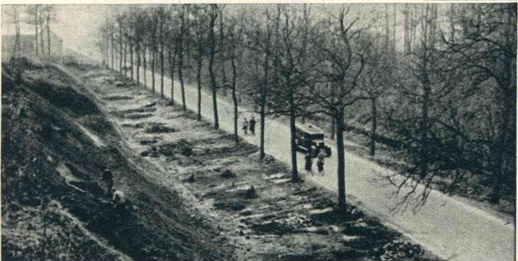
Men is bezig met een belangrijke verbetering van den gevaarlijken Kruisberg in den Rijksweg Sittard-Maastricht, die met een helling van 1-5 en een intensief verkeer met het Zuiden des lands en België menig slachtoffer eischte. Door het sloopen van een achttal woningen en het afgraven der bermen brengt men de kruinbreedte op 26 meter. Een overzicht van het werk.
