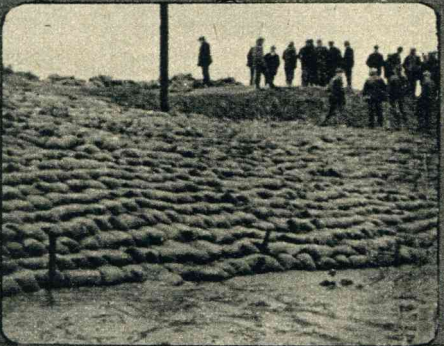
De dijk is met zakken zand versterkt....
