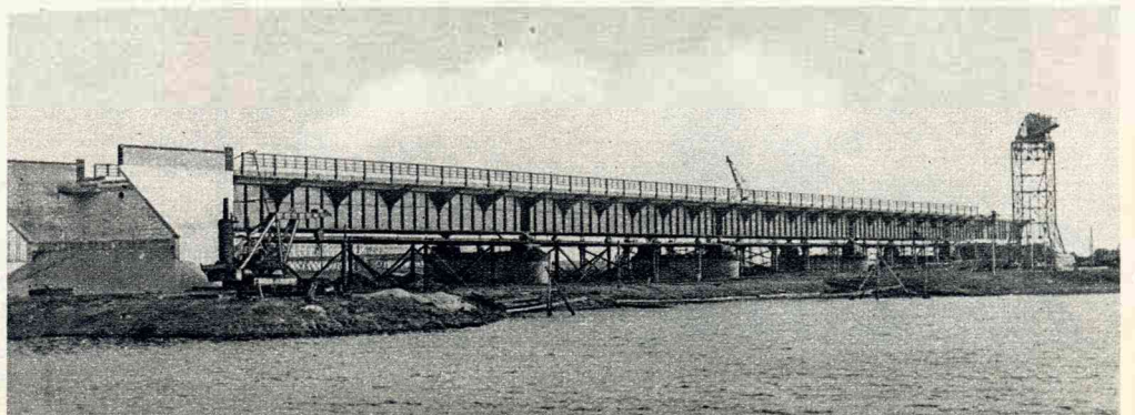
Het brugdeel aan den Noordelijken Maasoever bij Hedel is gereed. Thans kan aan den bouw der overspanning worden gewerkt. Nog in dit jaar zal de brug in gebruik kunnen worden genomen.
