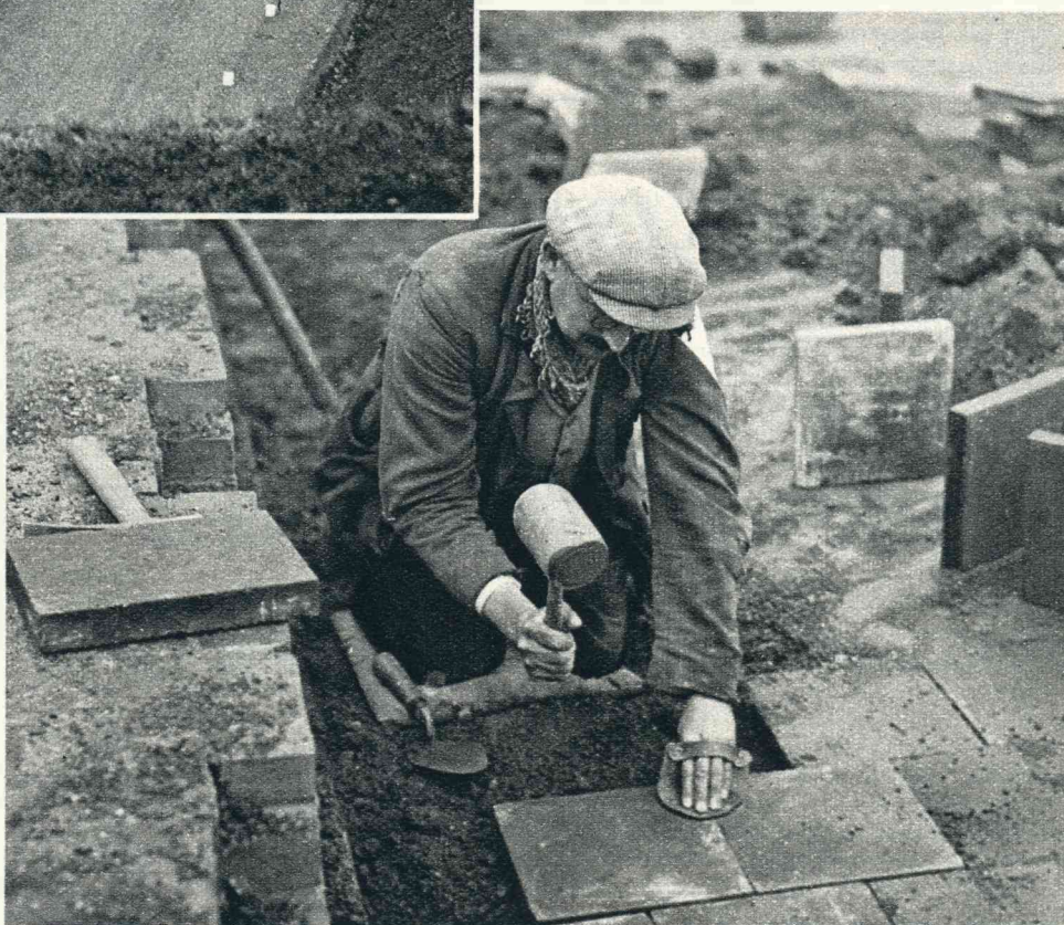
Het trottoir wordt gelegd.
