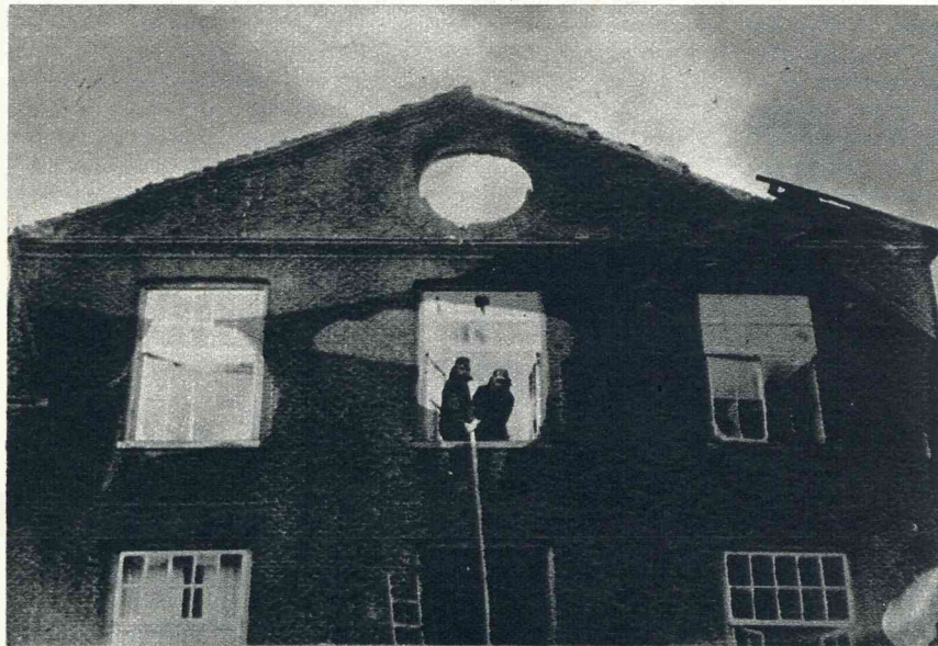
De kloosterbrand te St. Michielsgestel. — De brandweer in volle actie.
