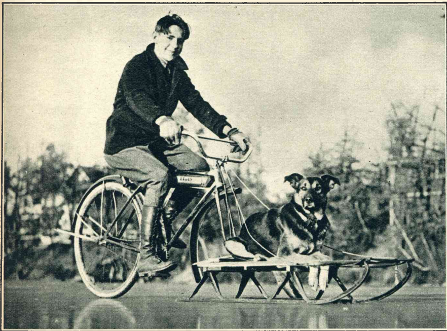
Een ijsfiets, waarmede men niet zal uitglijden, zelfs niet op de gladste ijsvlakte. Het zou ook voor ons land een practisch vervoermiddel zijn, als we niet gewoonlijk gezegend werden met een kwakkelwintertje met twee à drie dagen behoorlijk ijs.
