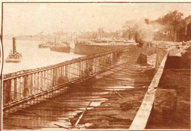
Aan de haven te Venlo is de ijzeren damwand reeds gereed en is de machine op den achtergrond druk bezig met het aanvullen van den nieuwen aanlegsteiger.
