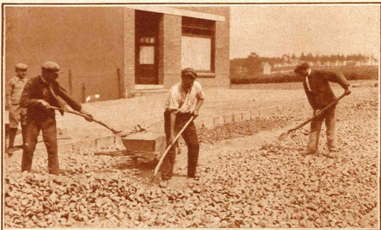
Alle straten van Versiellenbosch worden verhard, wat een groote verbetering beteekent. Alleen de voorbereidende werkzaamheden zijn voor de bewoners niet zoo aangenaam. Links: De weg wordt bedekt met een laag bezaltslag. Rechts: Een walsje er over en de weg wordt glad.
