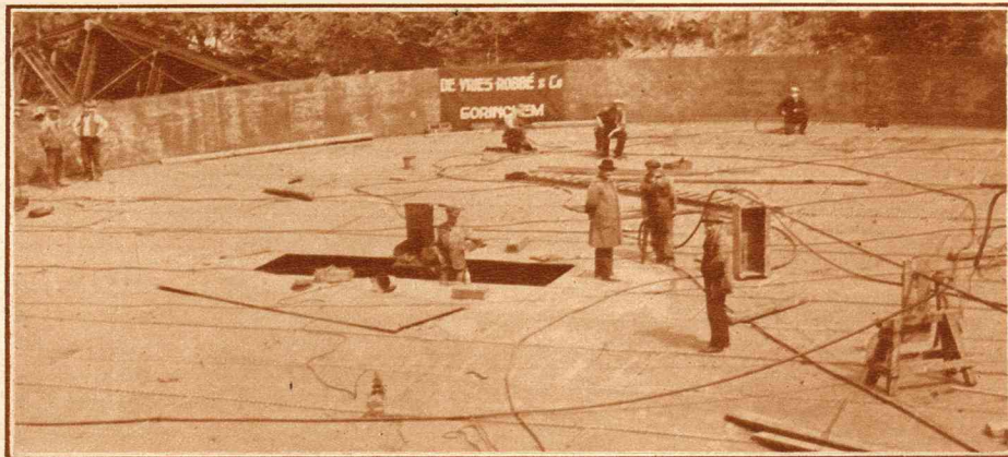
Te Sittard is men op het oogenblik druk bezig met het opbouwen van een nieuwen gasketel voor de betrekking van het gas uit de Staatsmijnen. Een kijkje op het werk.
