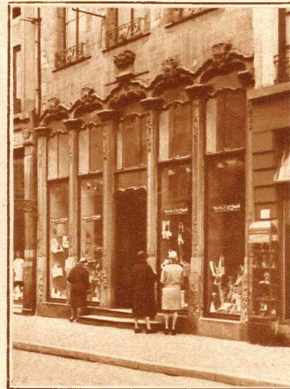
Het pand naast het oude Dinghuis, dat eveneens ingedeeld zal worden bij den raadskelder heeft geen mooien ouden gevel. Nu is een oplossing gevonden, doordat de oude benedengevel bij het pand van Vroom en Dreesman zal worden afgebroken en weer worden opgetrokken naast het Dinghuis. Het eigenaardige is, dat de gevel tot op de c.M. in de nieuwe omgeving past. Links: de plaats, waar de oude gevel zal komen. Rechts: de oude benedengevel van Vroom en Dreesman.
