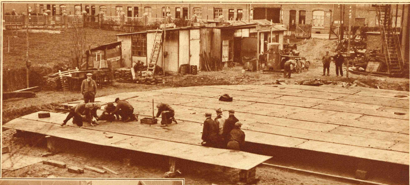
Sittard krijgt een nieuwen gashouder, welke het mijngas zal distribueeren. Momenteel is men bezig de vloerplaat te monteeren. Kijkje op het werk.
