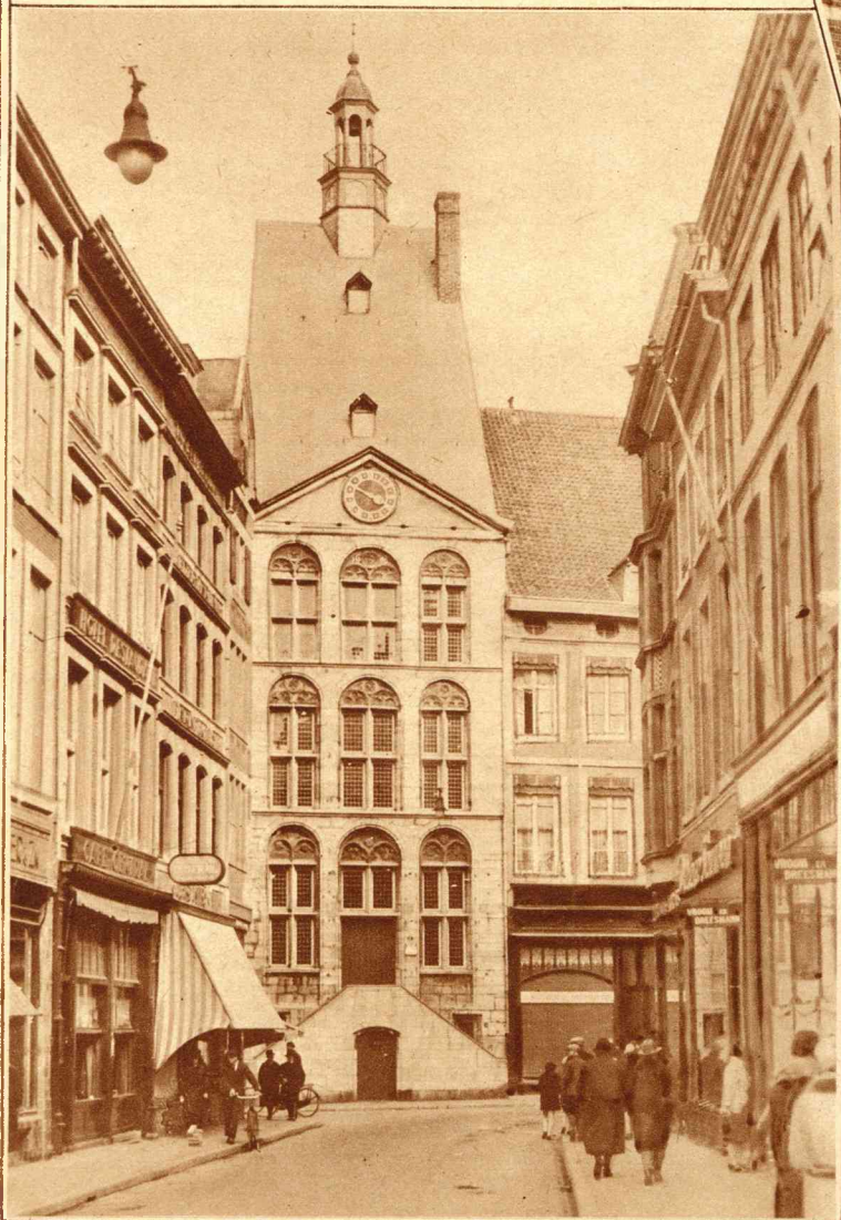
Het buitenaanzicht van het Dinghuis in de Groote Staat te Maastricht, dat als Raadhuiskelder zal worden ingericht.
