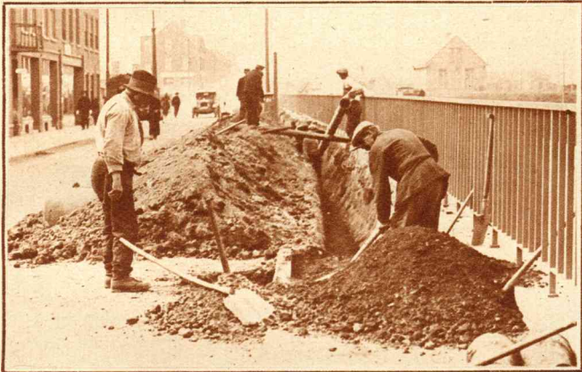
In Heerlen is men druk bezig met het leggen van een nieuwe voedingsgeleiding voor water naar Heerlerheide. Een overzicht op het werk.
