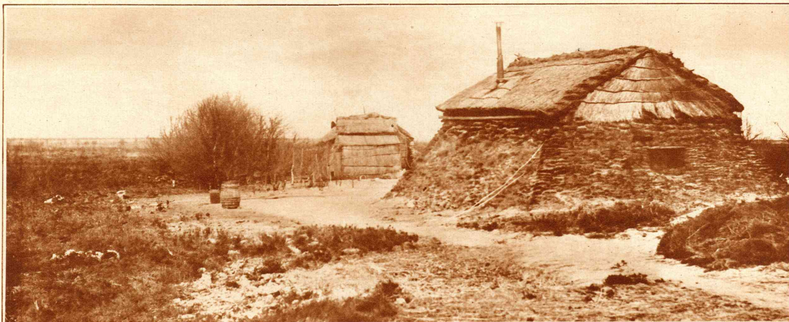
Waar geluk en zielenbrede behoeven geen grootsch paleis. De woning der veenarbeiders.
