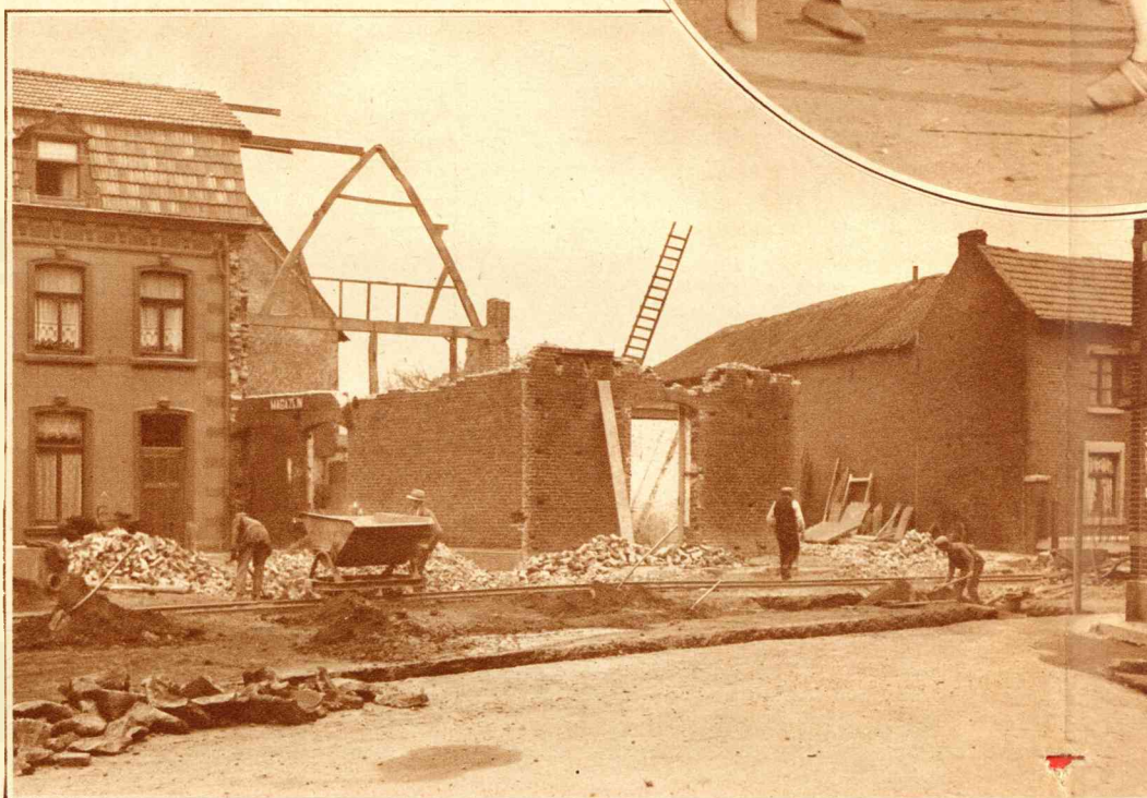
In Geleen is men bezig de overkapping voor de Geleenbeek onder de spoorrails door te leggen, zoodat de treinen tijdelijk over een afgrond moeten loopen. Werkzaamheden op het dorpsplein.
