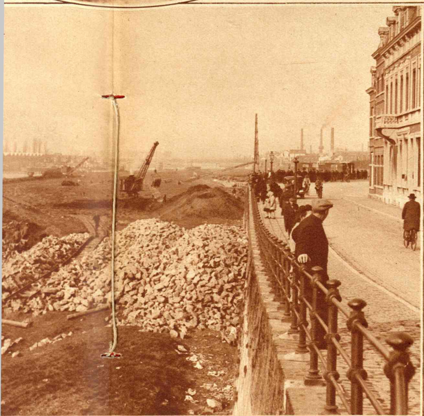
icht van de werkzaamheden voor de nieuwe Maasbrug.
