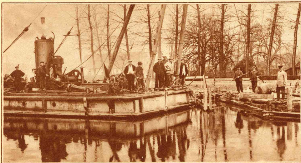
Te Weert (L) aan het kanaal is men druk bezig met uitbaggeren voor de neerlating der buizen voor het gas op verren afstand. Een kiekje van het werk.
