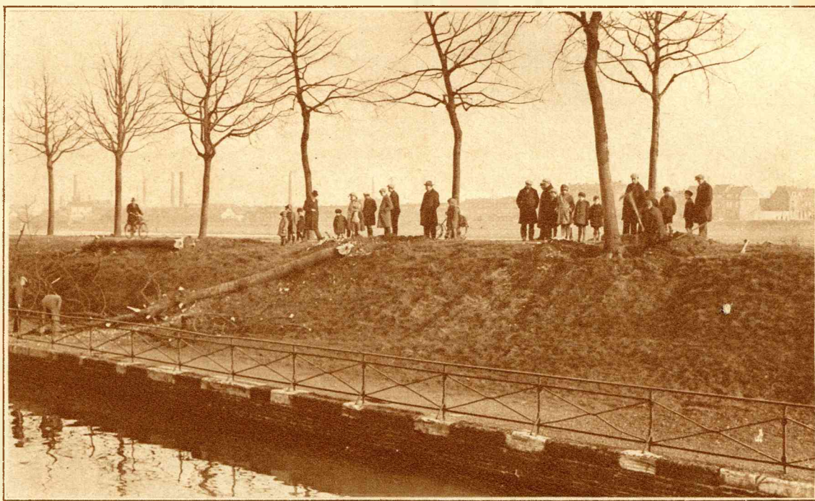
Te Maastricht heeft men een aanvang gemaakt met de voorbereidende werkzaamheden voor de nieuwe Maasbrug. Langs de Maas worden verschillende boomen geveld.
