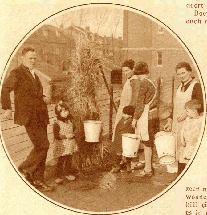
De pomp in Heer is van een winterjas voorzien.
