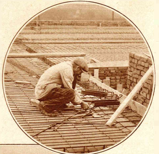
Een betonvlechter aan het werk op den bovenvloer.
