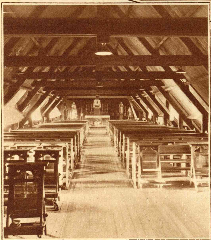
De groote zolder nan het gebouw is ingericht tot kapel.
