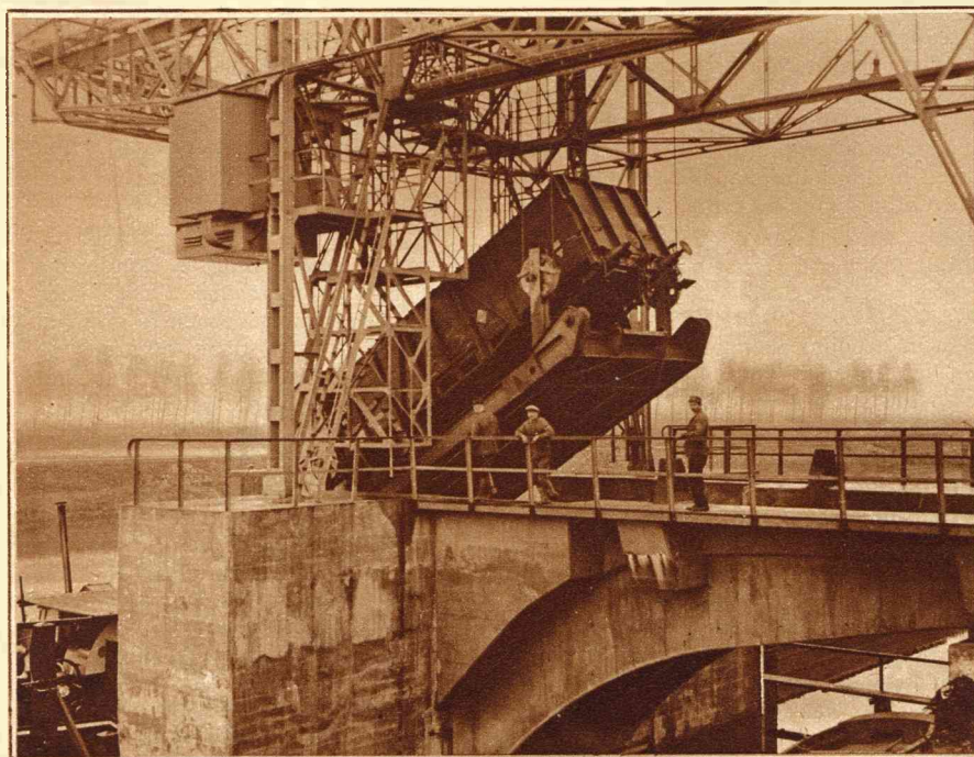
De kolentip te Maasbracht was in volle werking te zien, wat een interessant gezicht is. Wagons kolen van 20 ton worden als 'n veertje opgetild en in hun geheel leeggestort. Het kippen van den wagon.
