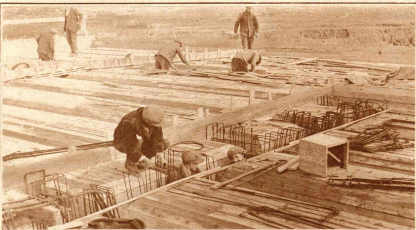
Werkzaamheden aan het nieuwe viaduct over den mijnspoorweg Staatsmijn Emma — Staatsmijn Maurits op de Rijksweg bij Geleen. Het aanbrengen van de bewapening voor het betonnen des.
