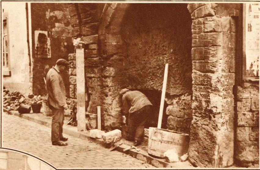
Te Valkenburg is men druk bezig de alom bekende Grendelpoort, die danig in verval was, te restaureren met een hardere steensoort, welke beter bestand is tegen den tand des tijds. Een gat onder de poort wordt gestopt.
