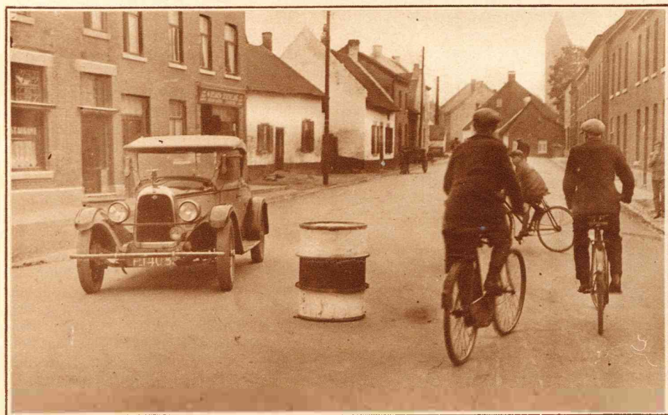
Het gemeentebestuur van Heer heeft, bij wijze van proef, op het gevaarlijke kruispunt aan den Rijksweg een verkeerston geplaatst. De bedoeling is om aan te toonen, dat het mogelijk is op die plaats een vluchtheuvel te maken. — Kijkje op de situatie.
