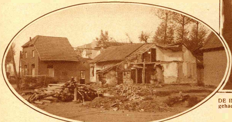
De huizen, welke den hoek vormen van de Burgem. Lemmenstraat, Tunnelstraat, Heidestraat te Lutterade worden afgebroken, zoodat er een belangrijke verkeersverbetering zal ontstaan.
