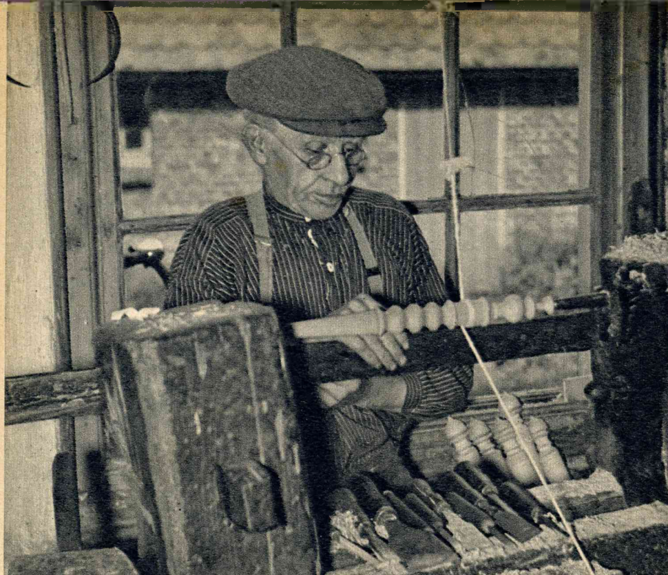
De laatste spinnewieler van Hellendoorn aan den arbeid: het draaien van de pooten.
