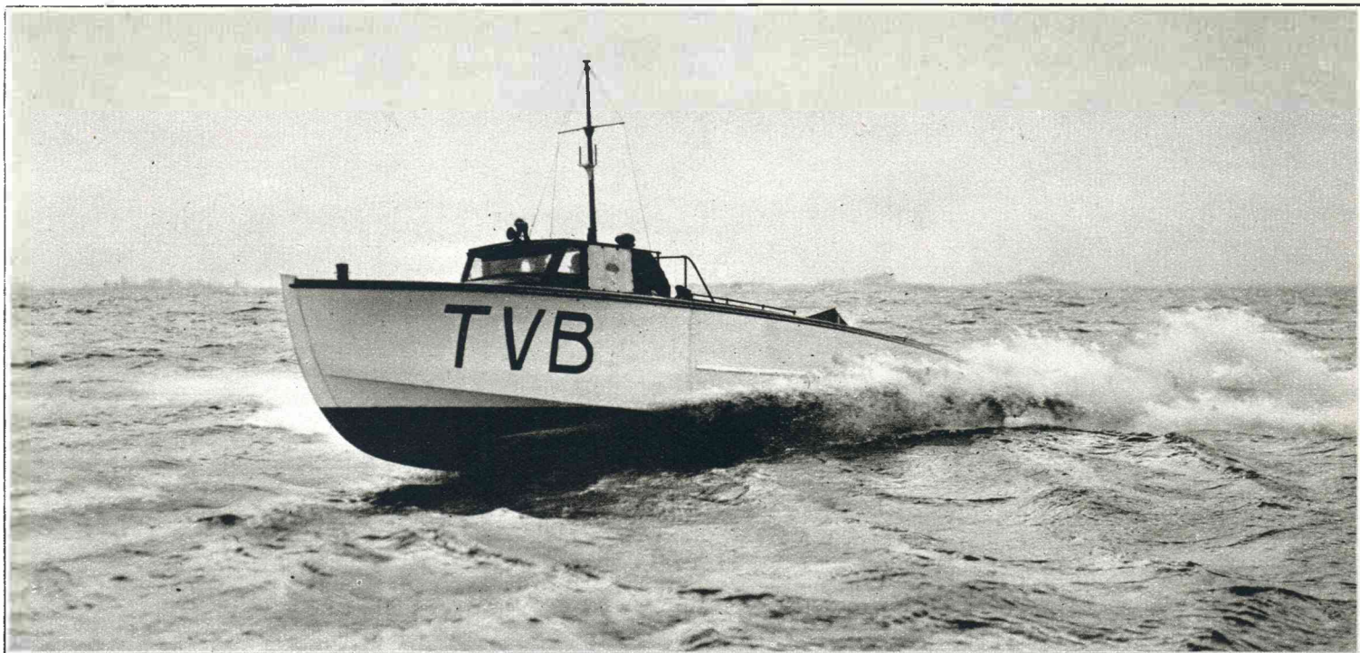
DE TORPEDO-VOLG-BOOT , geconstrueerd door den heer W. de Voogt te Haarlem, maakte op de Aalsmeersche plassen een proeftocht voor Marine-autoriteiten. De boot, die bestemd is voor Indië, heeft ten doel, bij oefeningen de gelanceerde torpedo's te volgen en op te vissen. De 500 P.K. motor kan aan het vaartuig een snelheid van 60 K.M. per uur geven.
