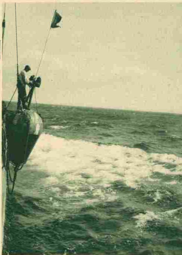
Het te water laten van een boei, om aan te duiden waar de kabel loopt.
