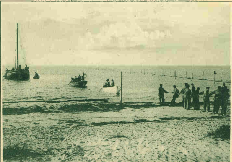
Het aan land brengen van den kabel aan de Zweedsche kust.
