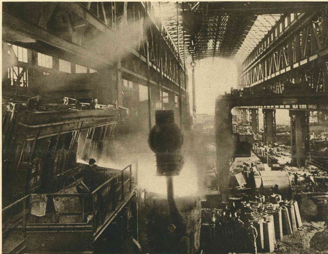
IJZER EN STAAL. — Kipbare Siemens-Martinoven (links). Het gereede staal wordt in een gietkroes afgelaten. Men vergeeljkje de afmetingen van den kroes met die der arbeiders rechts op den voorgrond.
