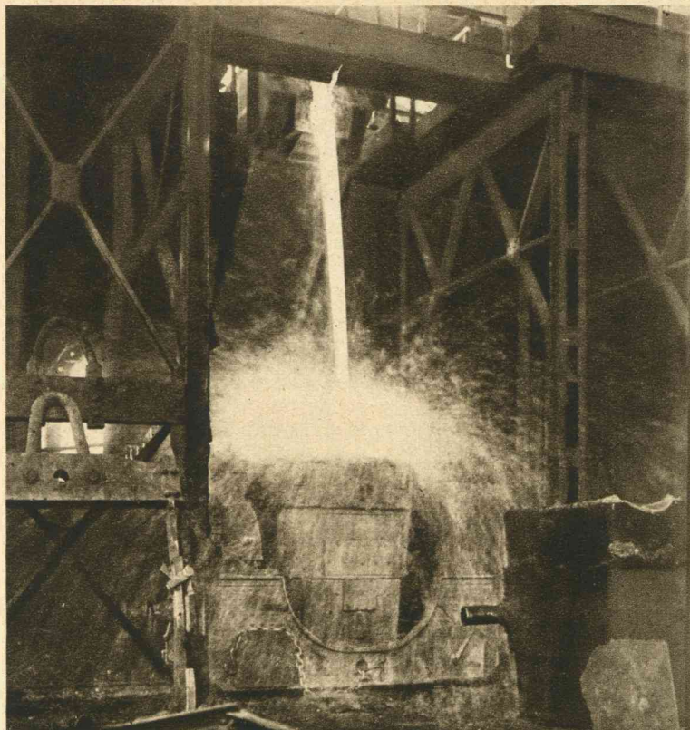
IJZER EN STAAL. — Het overgieten van het ruwijzer uit den menger in een transportwagen, welke het naar de Bessemerlei vervoeren zal.
