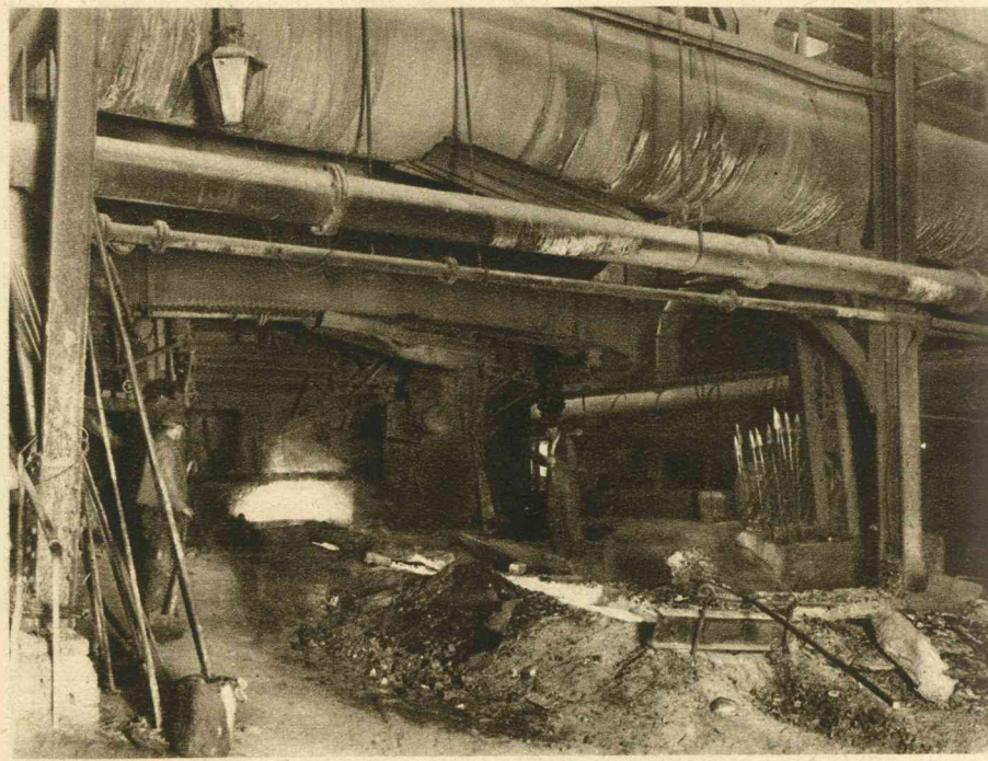
De voet van den hoogoven. — Het gesmolten ruwijzer wordt uit den oven afgelaten.
