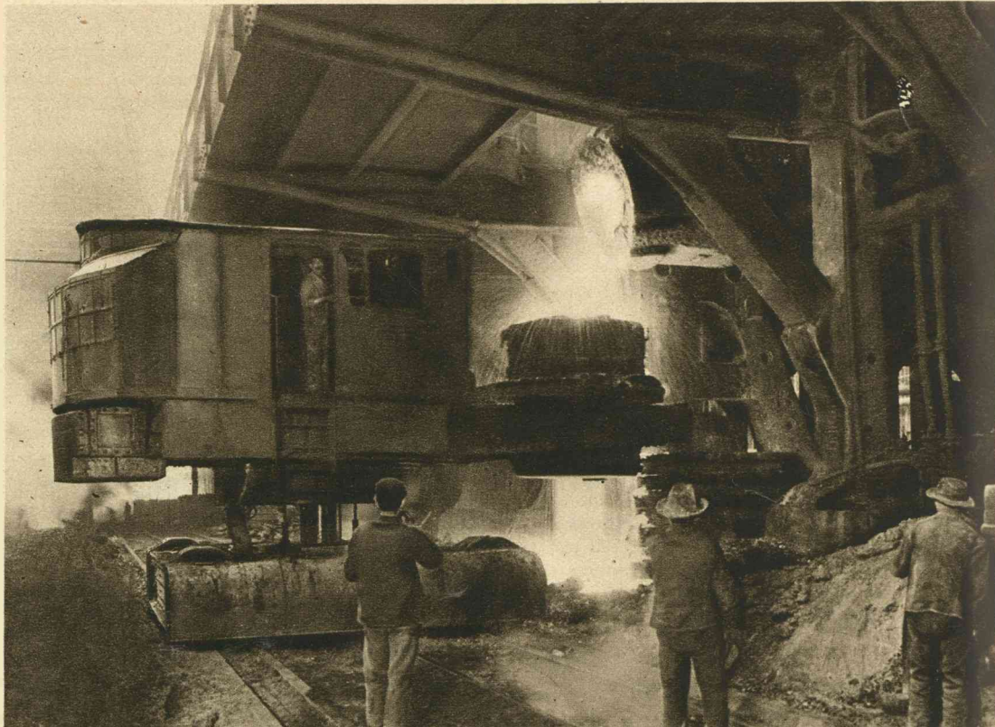
IJZER EN STAAL. — Het ledigen van een converter. Het gereede staal vloeit in een pannewagen.
