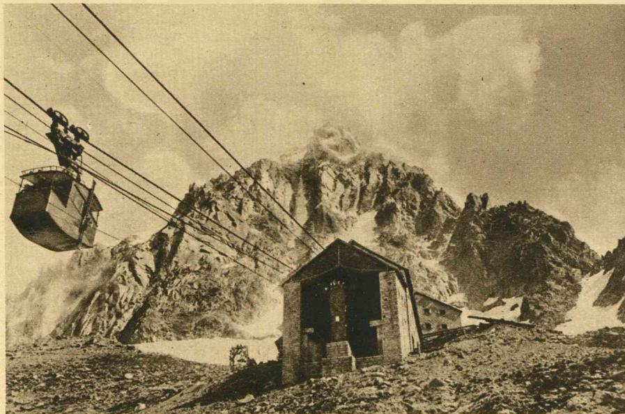
Het hoogste kabelspoor van de wereld
