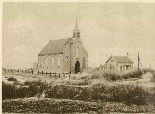
De „Groote kerk” te Hoek van Holland. Met het oog op de bepalingen van het fort is de kerk van hout gebouwd en wordt door staaldraden tegen omwaaien beveiligd.
