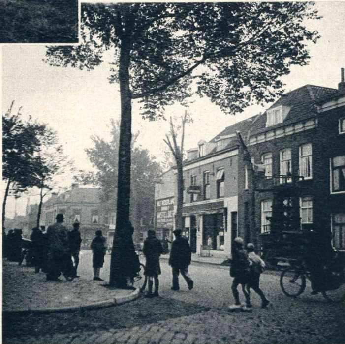
Aan de Badhuisstraat te Vlissingen werden enkele boomen gerooid, wat veel nieuwsgierigen trok.
