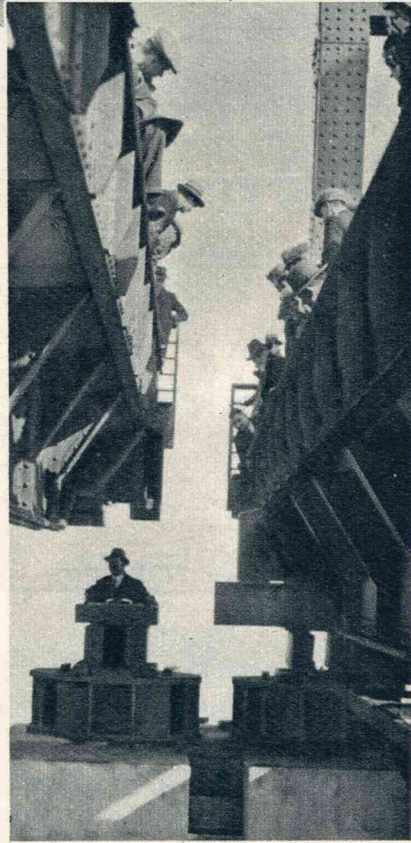
Een overspanning van de brug bij Moerdijk wordt in haar geheel ingevaren en....
