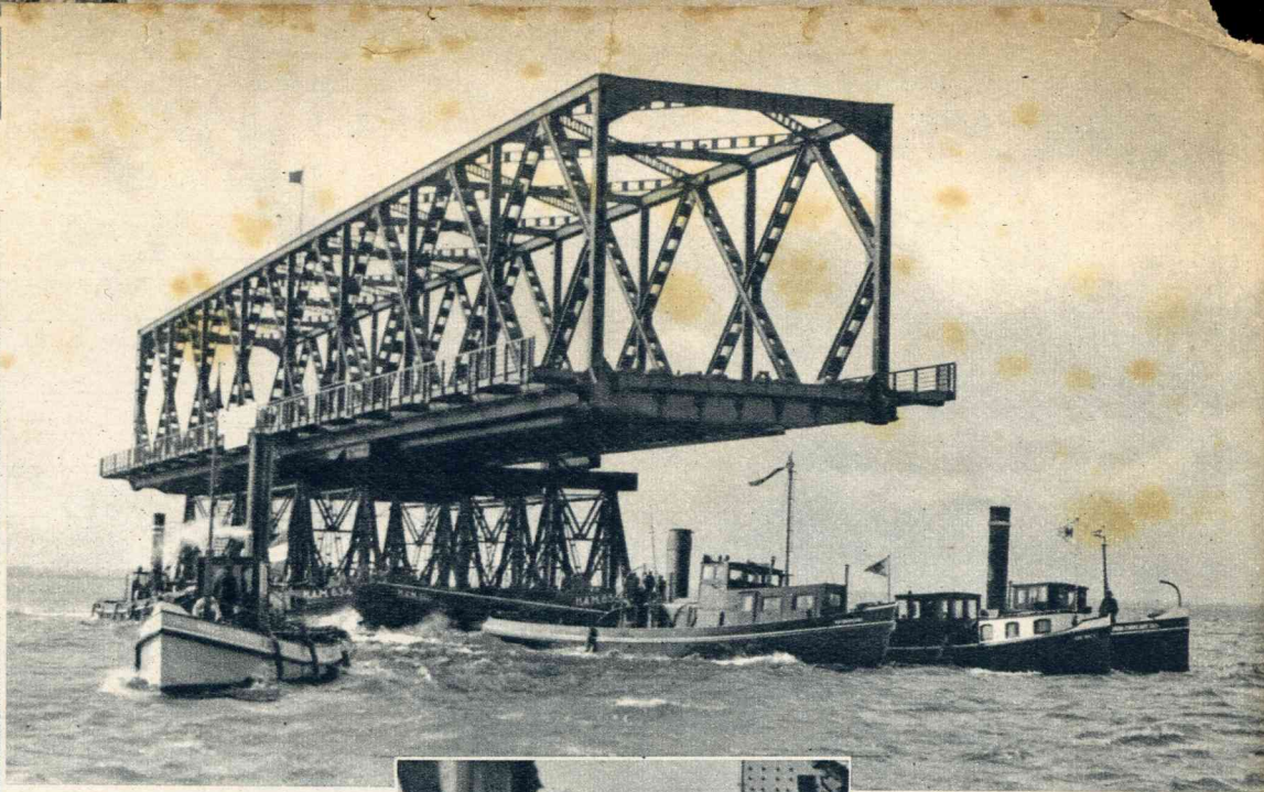
Een overspanning van de brug bij Moerdijk wordt in haar geheel ingevaren en....
