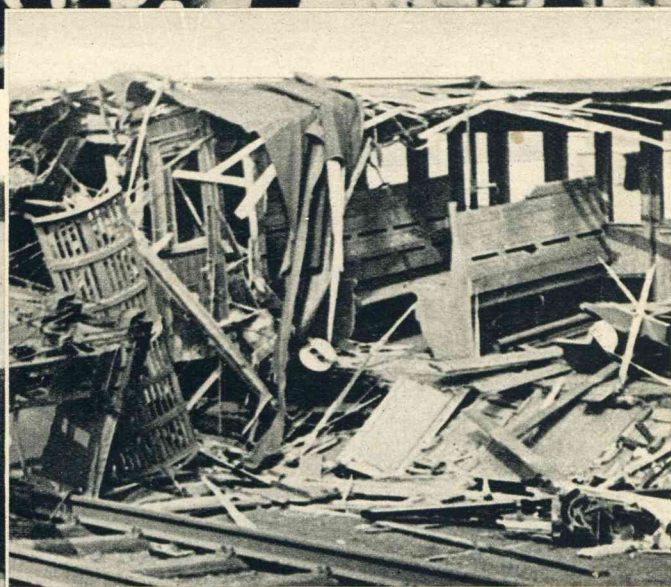
Nabij 't station te Sint Truiden (België) ontspoorde door een nog onbekende oorzaak het eerste rijtuig van een personentrein. Vijf passagiers verloren bij dit ongeluk het leven.
