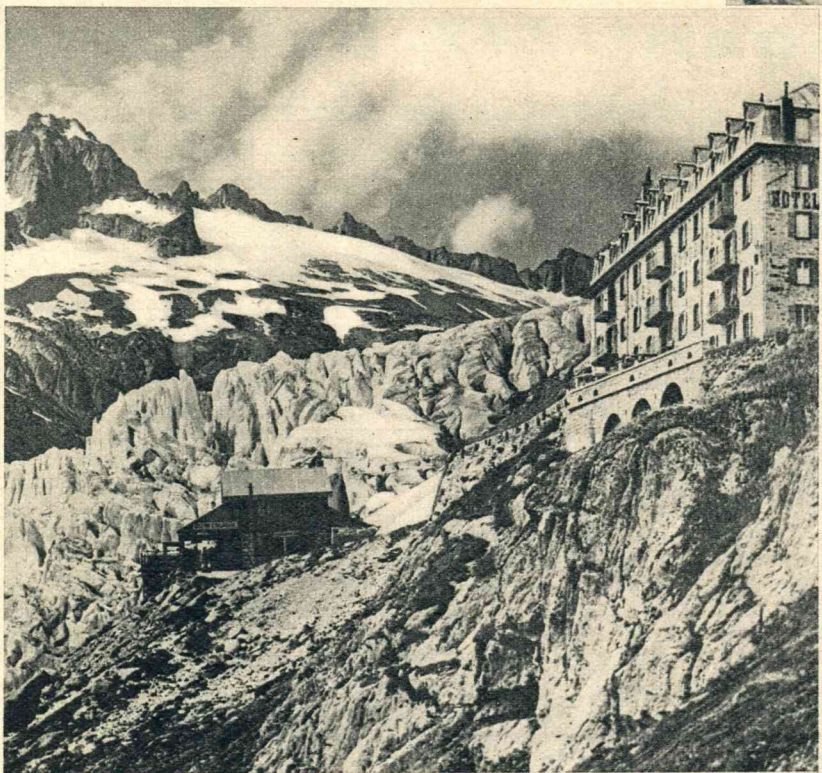
Het kleine gebouwtje in het midden van onze foto geeft toegang tot de gletschergrotten. De gemeente Oberwald verleende allerlei concessies aan de eigenaars van het nieuwe gebouw, zonder in 't minst rekening te houden met de eigendomsrechten van dr. Seiler. Deze echter stelde zich niet tevreden met de geschapen situatie en nam het gerecht in den arm.
