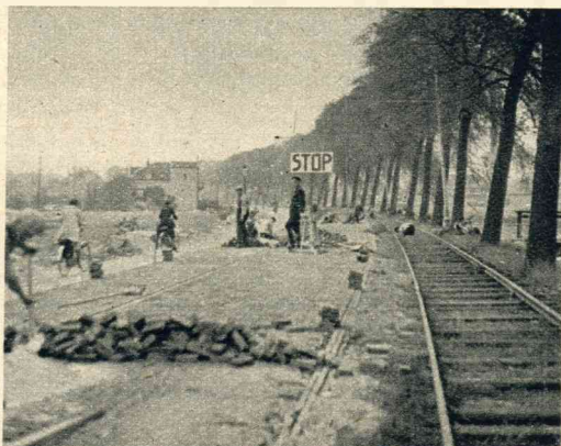
Bij de wegwerkzaamheden onder Middelburg wordt door de verkeerspolitie van een aan duidelijkheid niets te wenschen overlatend stopbord gebruik gemaakt: een nieuwigheid voor Zeeland.
