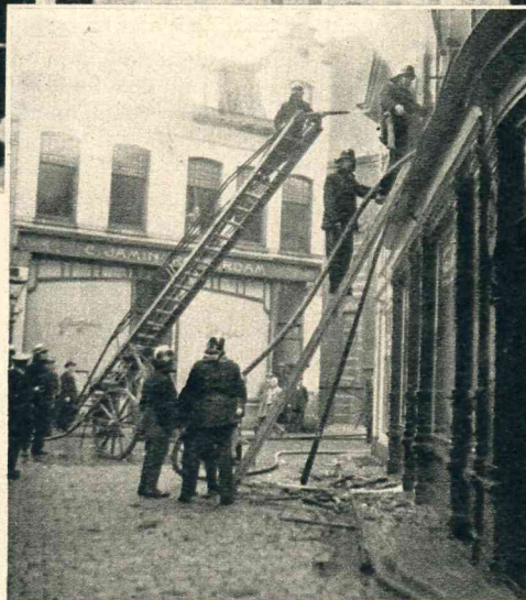
Een bewogen Zondagmorgen in Vlissingen: vermoedelijk door een ontploffing brak er brand uit in 't bovenhuis van slager te Roller aan de St. Jacobstraat. De laaiende vlammen bedreigden al dadelijk andere panden van de smalle winkelstraat, maar de brandweer had het gevaar spoedig tot het bovenhuis beperkt en bezworen.
