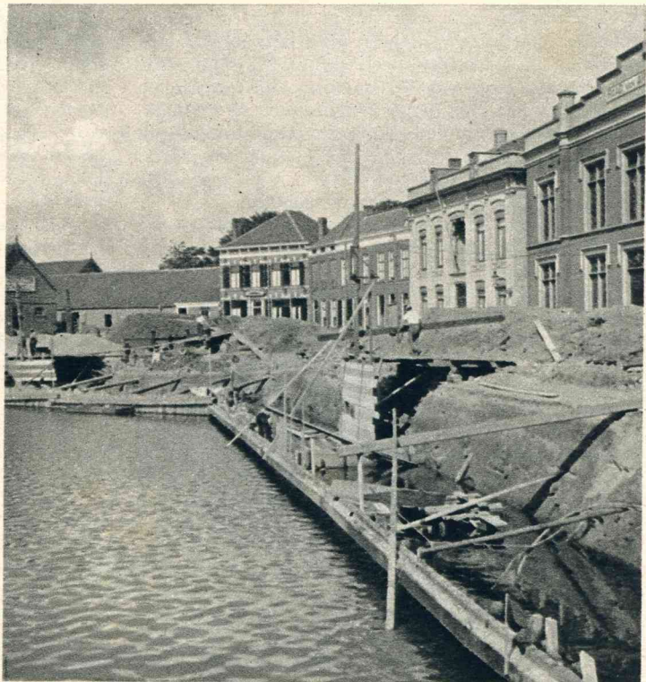
Met de werkzaamheden aan de uitbreiding en verlegging van de Goesche haven is men thans ook tot in de stad zelf gevorderd, waar de kaden nu wel een heel ongewoon schouwspel opleveren.
