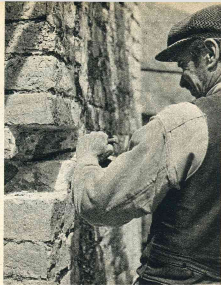
Ook uit het metselwerk worden de verweerde steenen weggehakt om door gaaf materiaal vervangen te worden.
