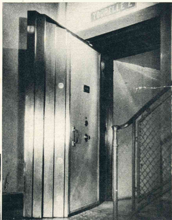
De deur van den eenigen toegang tot den 28 meter diepen put. De deur — natuurlijk van staal — is tachtig centimeter dik en zoodanig geconstrueerd dat noch dynamiet, noch eenig ander ontploffingsmiddel er ook maar den minsten vat op heeft.
