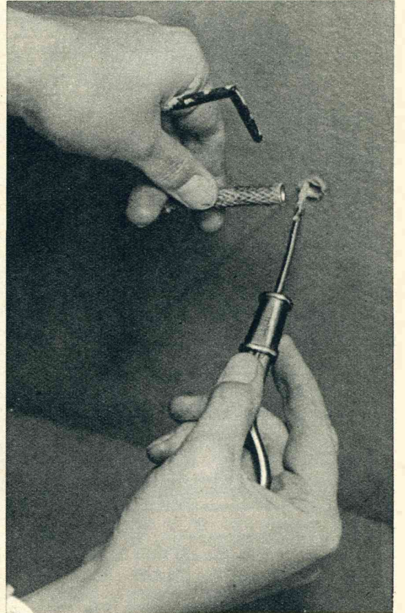
We brengen eerst wat gips in het met een speciaal boortje gemaakte gat.
