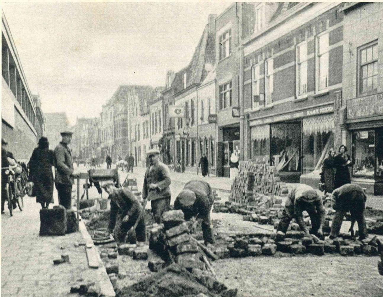
Te Vlissingen ondergaat het wegdek van de Walstraat een grondige verbetering; in zoo'n centrumstraat geeft dat nog al wat hinder en daarom wordt er met man en macht aan gewerkt.
