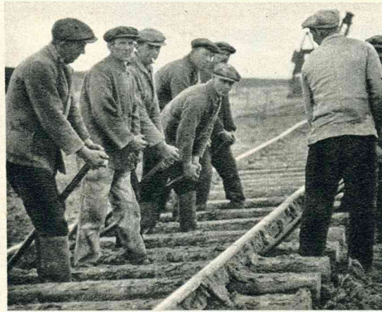
De rails worden gelegd voor den zandtrein, die daar voor de ophooping van de terreinen dagelijks honderden kubieke meters zand aanvoert uit de omgeving van Woude.
