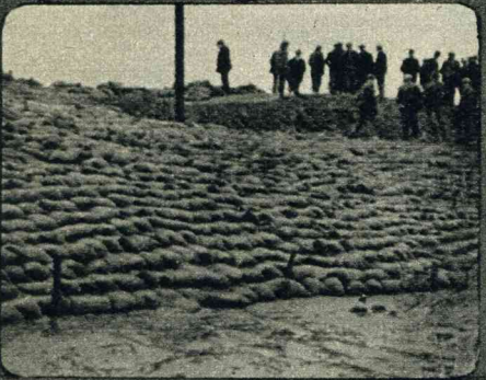
De dijk is met zakken zand versterkt....
