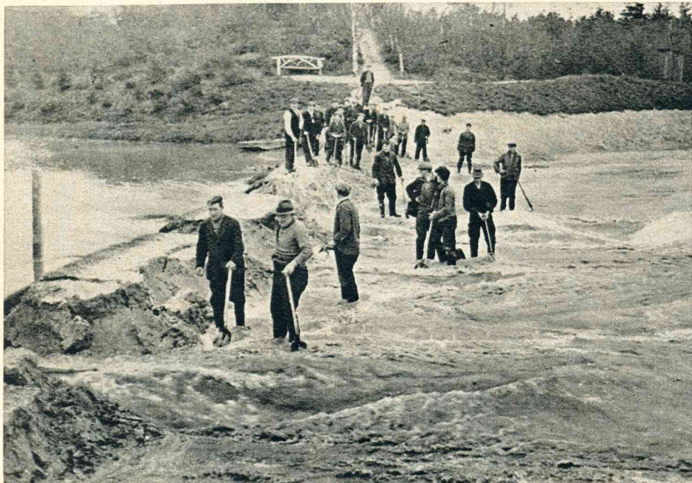
Achter het openluchttheater Birkhoven te Amersfoort is een vijver gegraven ter werkverschaffing. — De dam wordt doorgestoken, de vijver loopt vol.
