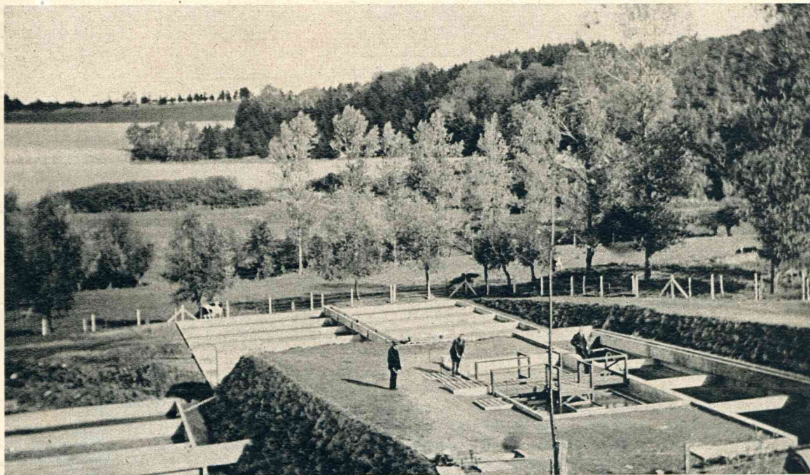
In Vuals kwam, onder leiding van den heer A. Lamsjus, gemeente-architect, de eerste rioolwaterzuiverings-inrichting tot stand, waarvan we hier de foto plaatsen.
