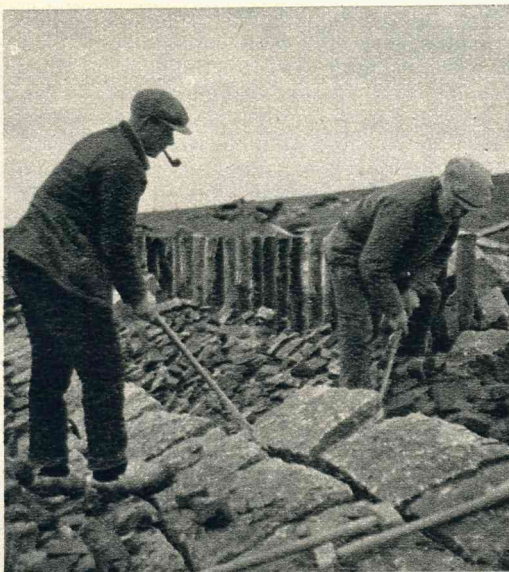
De werkzaamheden bij den dijk van den Willem Anna-polder aan den Biezelingschen Ham vragen nog steeds de aandacht. De beschadigde glooiing wordt thans hersteld.
