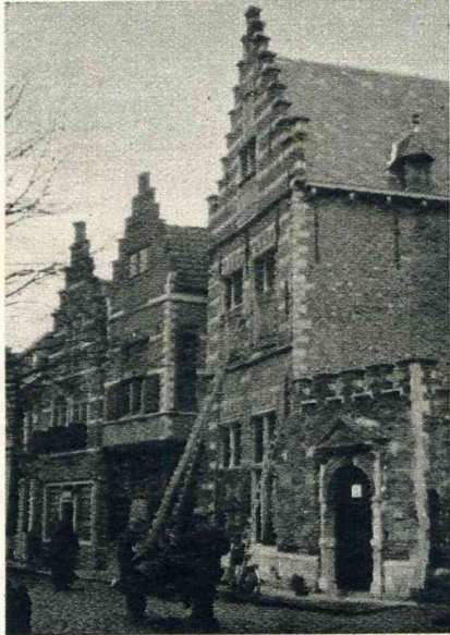
Aanleg van de illuminatie voor de Middelburgsche fraaie gevels op de Balans.
