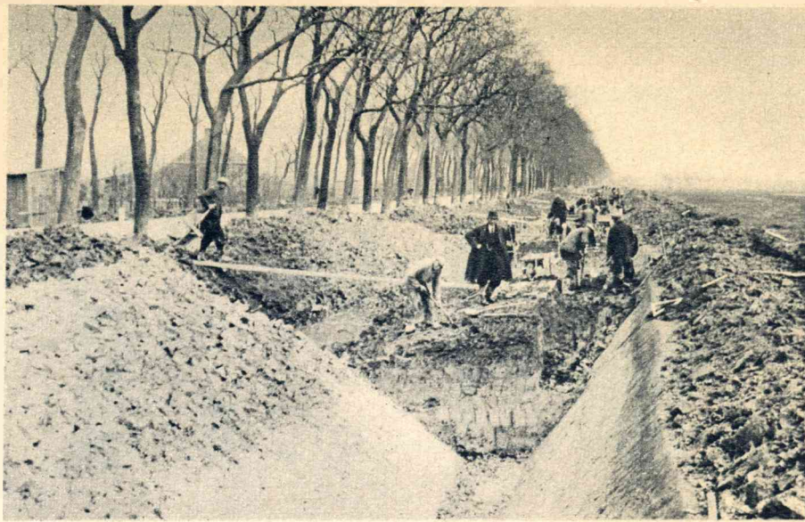
De weg Leeuwarden-Harlingen moet het grootendeels nog doen zonder rijwielpad. Thans wordt er een aangelegd buiten de boomenrij; de bestaande sloot wordt gedempt, daarnaast wordt een breedere en diepere sloot gegraven. (Polygoon)
