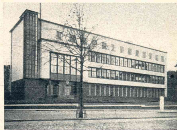
De Provinciale Geldersche Electriciteits Maatschappij heeft aan de Utrechtschestraat te Arnhem een nieuw administratiegebouw in gebruik genomen.
