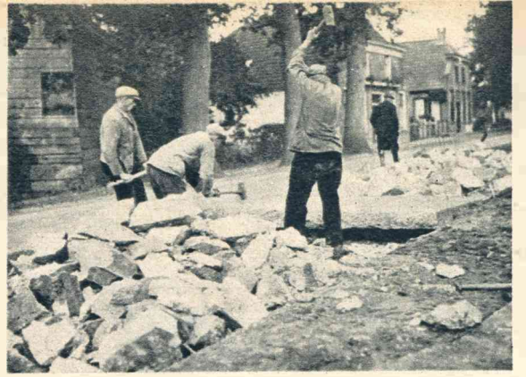
Te Staphorst is men bezig een aansluiting te maken op den nieuwen rijksweg Zwolle-Meppel. Een gedeelte van het slechts enkele jaren terug gelegde betonnen wegdek moet nu opgebroken worden.
