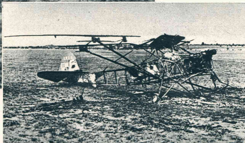
Bij het bombardeeren van de landingsterreinen werden dikwijls vliegtuigen getroffen, die onmiddellijk in brand geraakten. Het geraamte van een Poolse machine.
