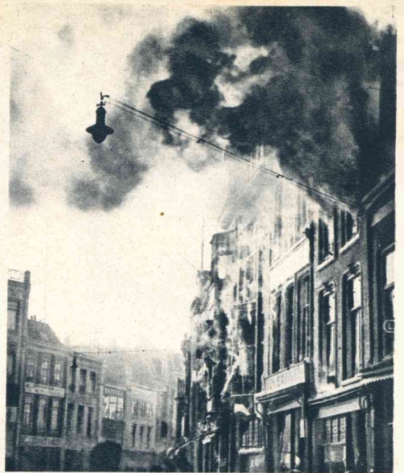
Te Utrecht brak brand uit in het gebouw van de firma Bayer aan den Steenweg. Een merkwaardige opname van de uitslaande vlammen.
