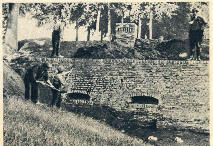
Elburg is druk bezig met het uitgraven van zijn middeleeuwse vestingwerken. In den muur kan men duidelijk een tweetal schietgaten onderscheiden, terwijl daarboven een luchtkoker zichtbaar is.
