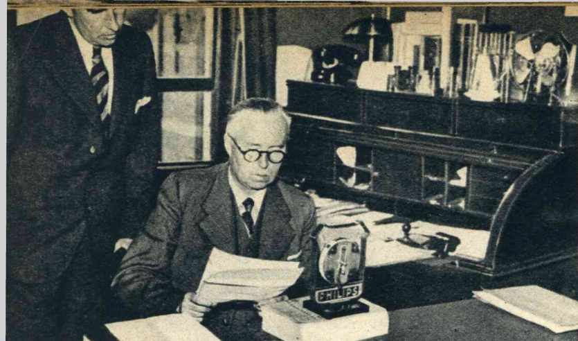
De luchtbeschermingsdienst te Oulenburg beschikt over een radio-installatie, waarmee op bepaalde uren de bevolking kan worden opgeroepen of gewaarschuwd. Burgemeester I.J. Kestra voor de microfoon in zijn werkkamer te stadhuize; links de heer W. E. J. Bollée, commissaris van politie en hoofd van den luchtbeschermingsdienst.
