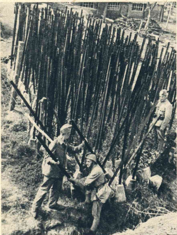
Prikkeldraadversperringen vindt men thans op diverse plaatsen aan onze grenzen. De lange ijzeren staven, waarlangs het prikkeldraad gespannen wordt, zijn voorzien van een zwaren betonnen voet.
