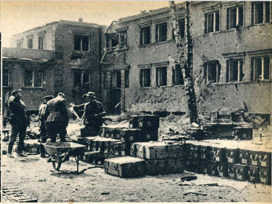
De Poolse bezetting van de Westerplatte moest zich na hevigen tegenstand overgeven. Duitsche soldaten onderzoeken de voorradige munitie.
