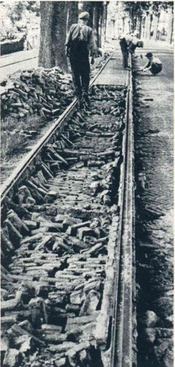
Nu de tramlijn Groningen-Haren-de Punt is opgeheven worden rails en bovenleiding met spoed weggebroken.
