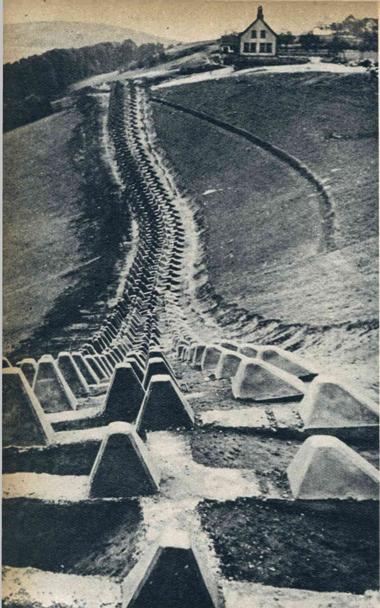
De betonnen tankafweerpalen, die deel uitmaken van de versterkingen aan de Duitse westgrens, den zg. Westvall.
